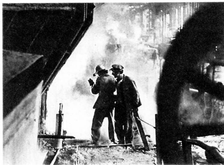
В. МАЧАБЕЛИ МАРТЕНОВСКИЙ ЦЕХ РУСТАВСКОГО МЕТАЛЛУРГИЧЕСКОГО
